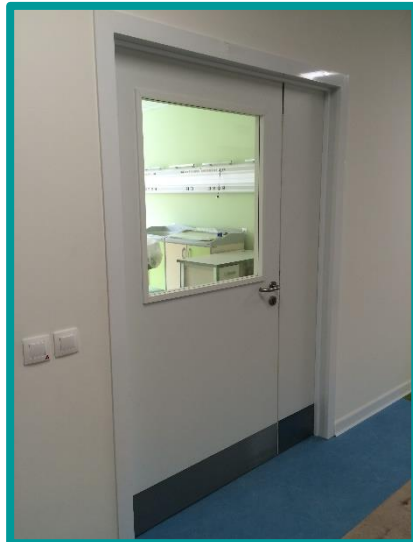
Классическое остекление с деревянным штапиком
