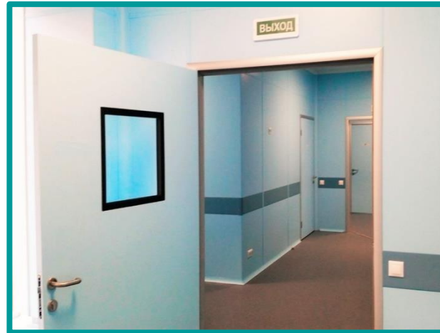
Остекление без штапика. Стекло вклеивается заподлицо с полотном.
